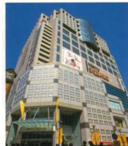
Hachioji Square Bldg.
