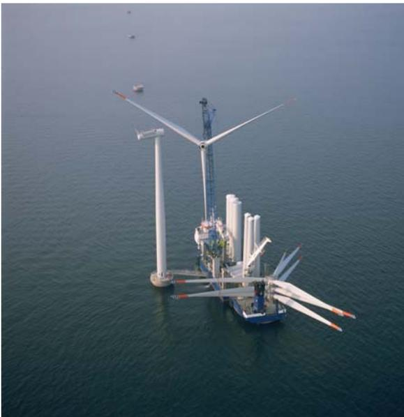
(図表 21 ) ナセルとブレードの設置工事
