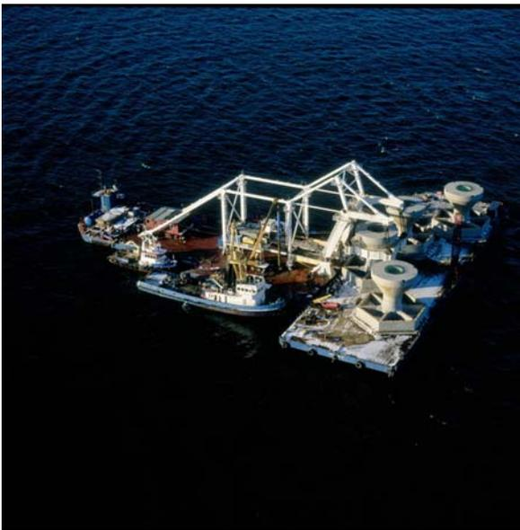
(図表 20 ) 重力式基礎部の設置工事
