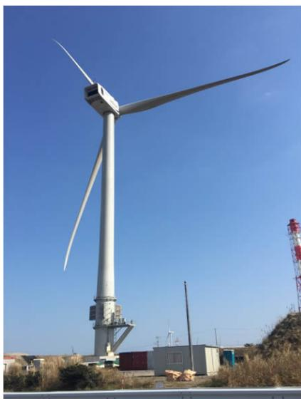
(図表 47) 日立製作所 5MW ダウンウインド型風車「HTW5.0-126」初号機 出典) 日立製作所
