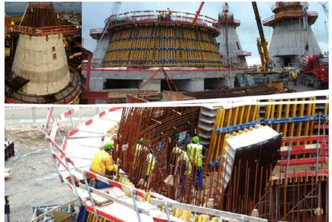
(図表 12 ) 基礎部 Gravity Foundation の組立
