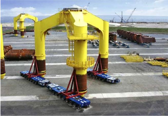
(図表 15 ) Tripod の搬送の様子
