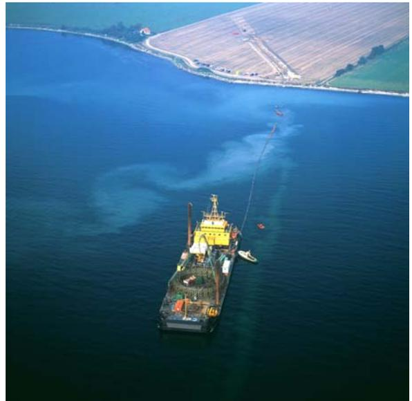
(図表 22 ) 海底電力ケーブルの敷設工事
