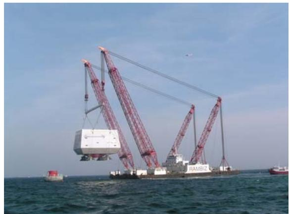
(図表 23 ) 洋上変電所の設置工事
