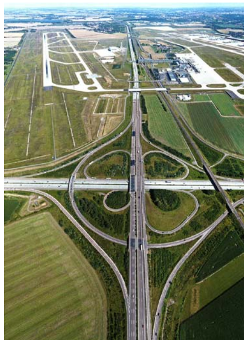
図表 91 ライプチヒ・ハレ空港全景 出典）ライプチヒ・ハレ空港
