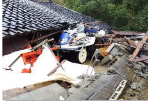
倒壊した倉庫と農機具
