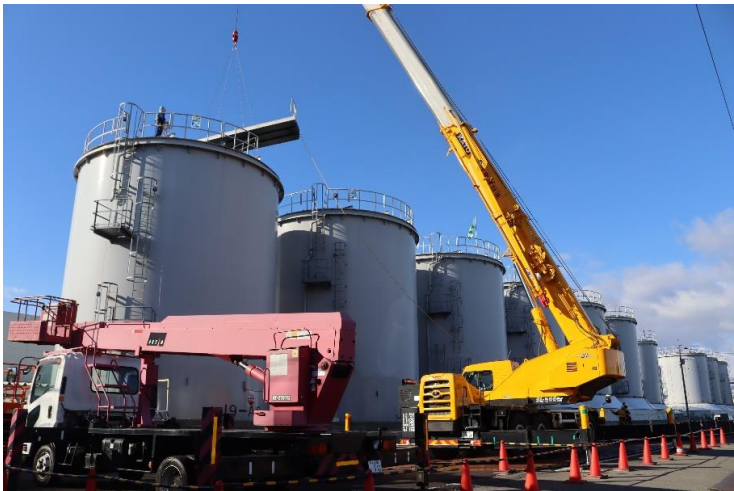
タンク上部（天蓋）を撤去する様子
