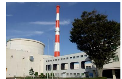
高速実験炉「常陽」
