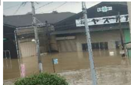
水害発生時の様子
