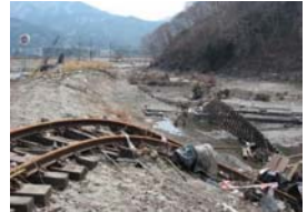
E【線路流失】 E【線路流失】 (大船渡線 細浦構内)
