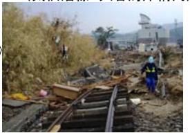
J【道床流失】 J【道床流失】 (仙石線 野蒜構内)
