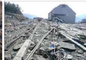
L【線路流失】 L【線路流失】 (常磐線 新地構内)
