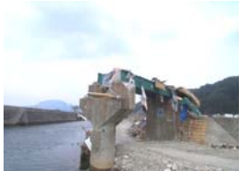
F【線路流失】 F【線路流失】 (大船渡線 陸前矢作～竹駒)
