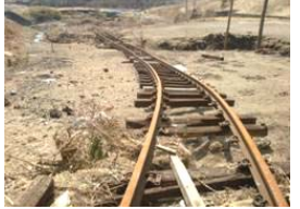
D【橋けた流失】 D【橋けた流失】 (山田線 陸中山田～織笠)
