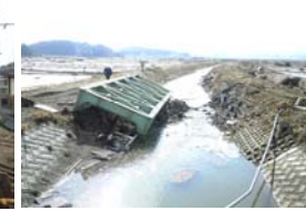
b【橋桁流失】(吉浜～唐丹)
