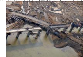
K【橋けた流失】 K【橋けた流失】 (常磐線 新地～坂元)
