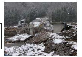
【参考】三陸鉄道 しまのこし a【高架橋・桁流失】(島越駅付近)
