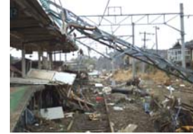
【参考】三陸鉄道 しまのこし a【高架橋・桁流失】(島越駅付近)
