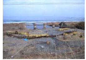
C【線路流失】 C【線路流失】 (山田線 磯鶏～津軽石)
