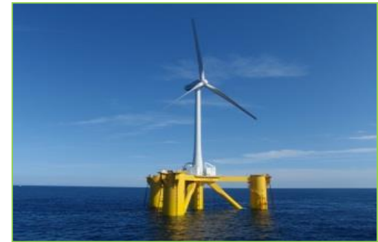
浮体式洋上風力発電システム
