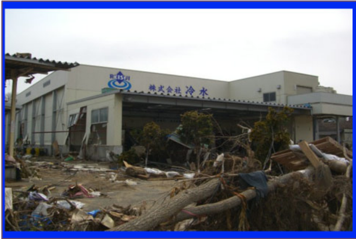
冷水 第二冷蔵庫
