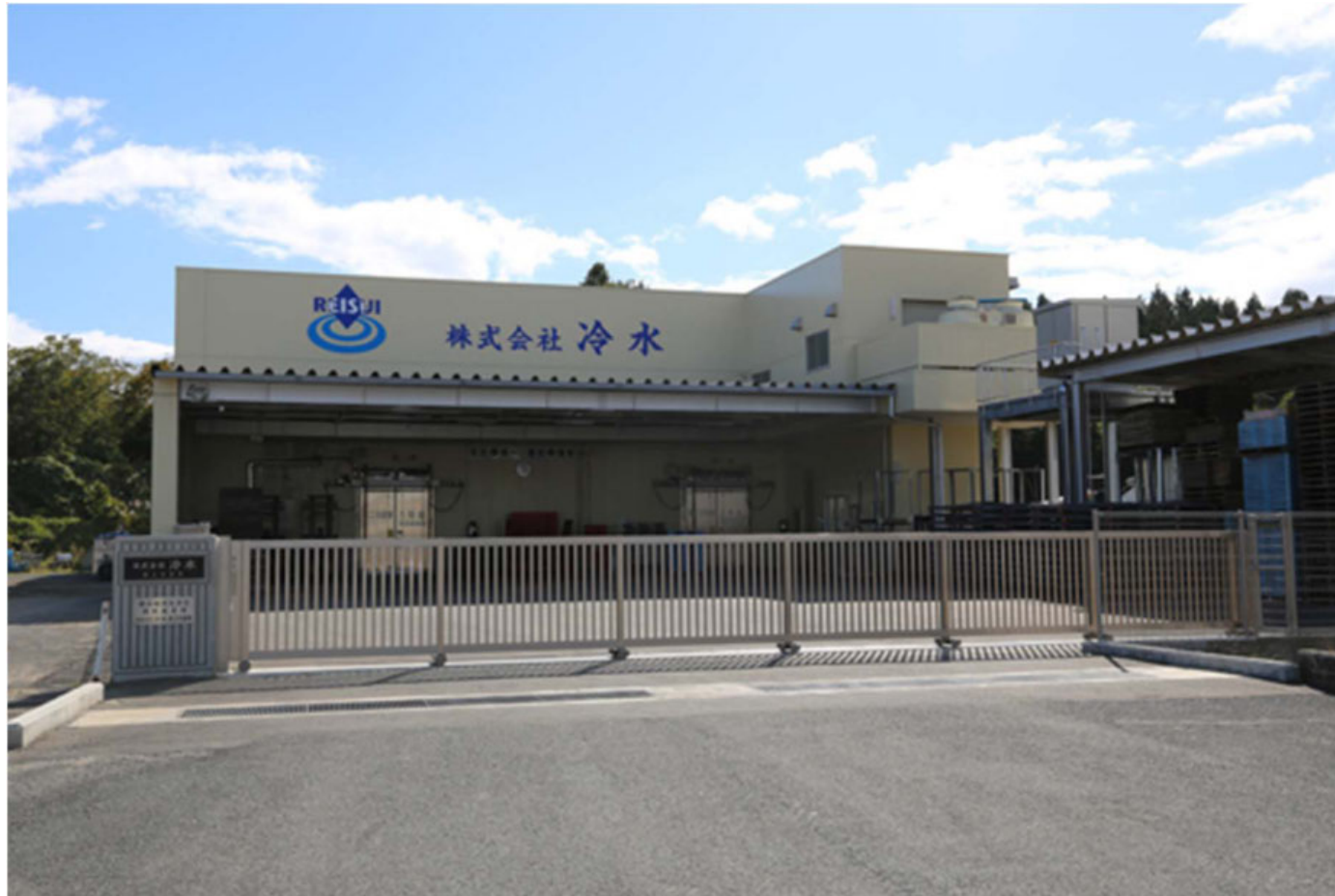
冷水 第二冷蔵庫
