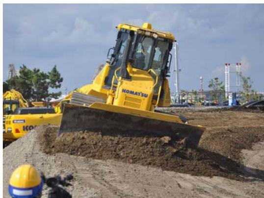
(図表 52)ブレードを自動制御しながら、傾斜の盛土・整地を行う
