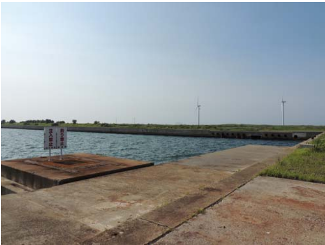
(図表 13) 風車の部品の保管場所として土地の耐荷重性を上げる工事を行う予定の岸壁
