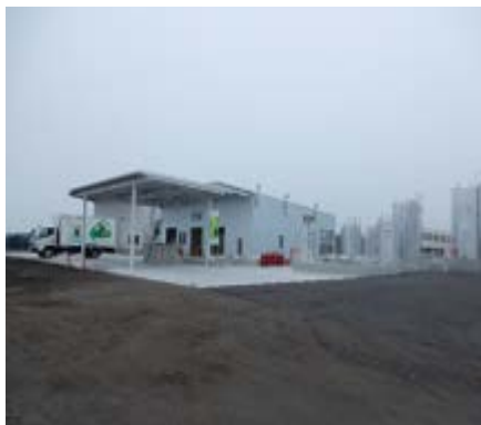
平成28年3月に移転した新工場
