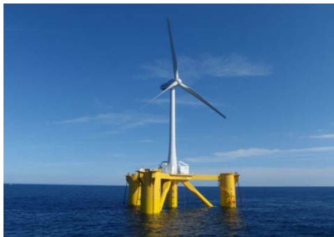
2MW浮体式洋上風力発電設備
