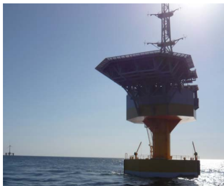
浮体式洋上サブステーション(変電設備)
