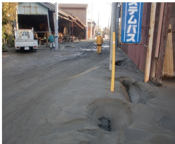
千葉県香取市・・・液状化により被災した製材業者の敷地
