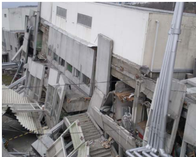
福島県須賀川市・・・地震により半壊した工場
