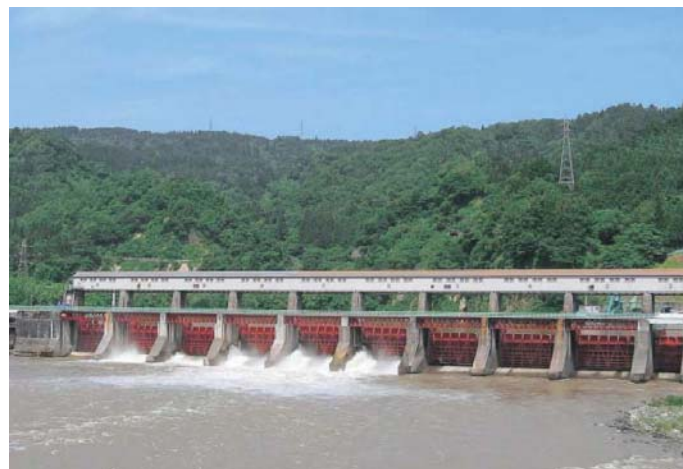
信濃川発電所
