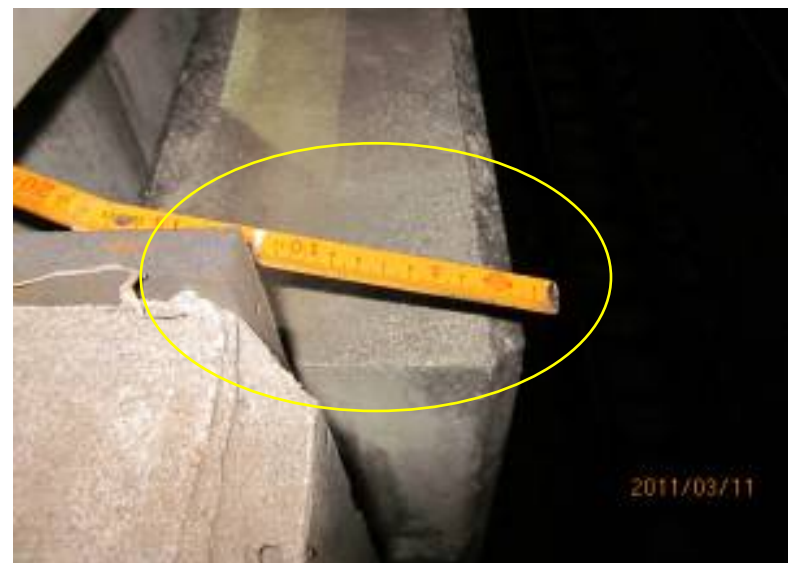
(上)路盤陥没 (下)土留壁ズレ
