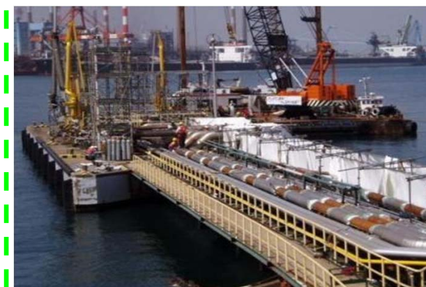
復旧が進む鹿島製油所の出荷栈橋
