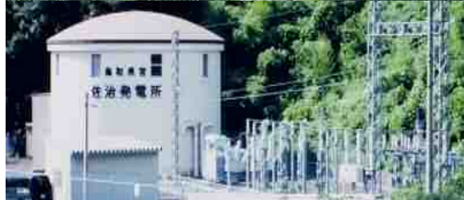
佐治川ダムと佐治発電所
