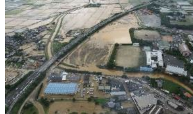
③桂川における浸水被害 (福岡県朝倉市)
