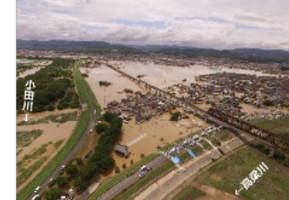
④小田川における浸水被害 (岡山県倉敷市)
