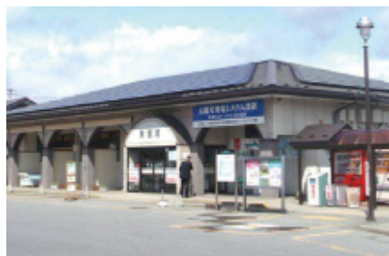
勾配屋根設置
