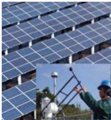
2.4MWソーラ発電所
