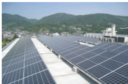
屋上架台設置
