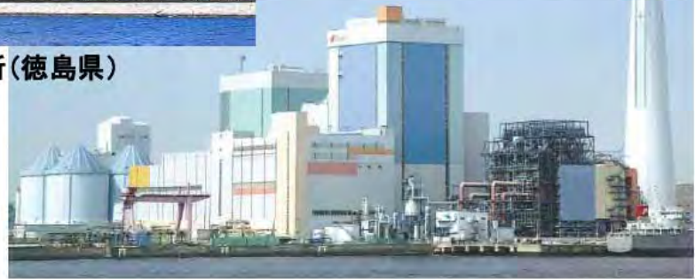
Jパワー磯子火力発電所(神奈川県)
