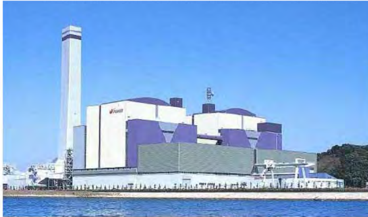
Jパワー橋湾火力発電所(徳島県)
